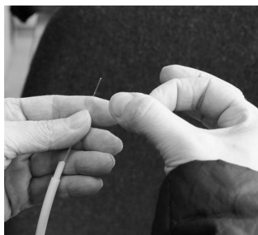
Рис. 10. Обламывание оптоволокну
