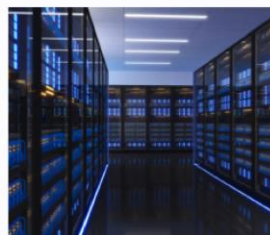
Тестирование надежности источника питания сервера
