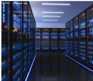
Тестирование надежности источника питания сервера
